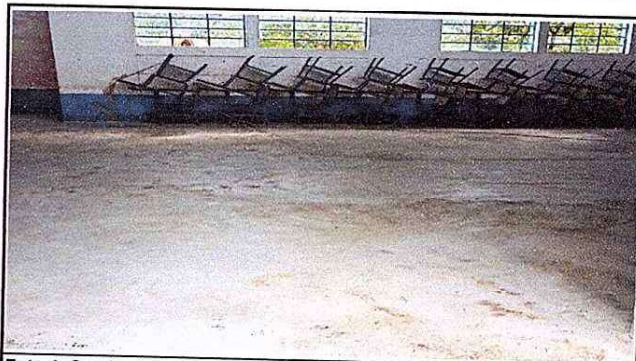
Foto 4: Sustrucción de piso de aula finalizado
