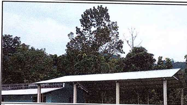
Foto 1: Sustrucción de láminas finalizado
