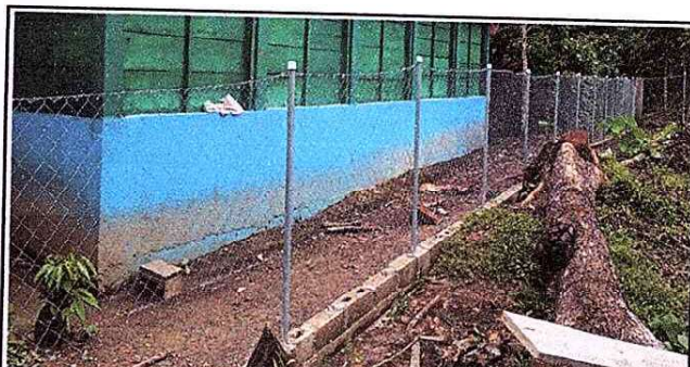
Foto 6: Sustrucción de malla perimetral finalizado
