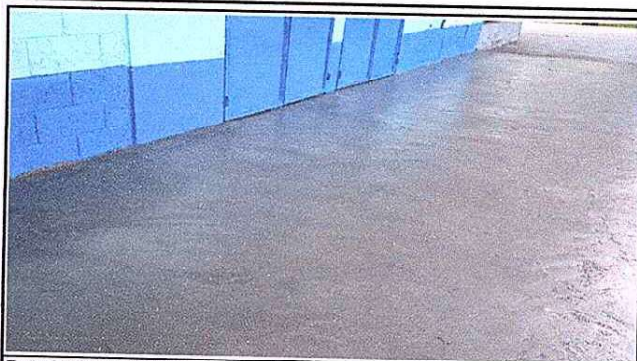
Foto 2: Mantenimiento de piso de corredor finalizado
