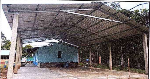
Foto 3: Sustrucción de base de madera a concreto finalizado
